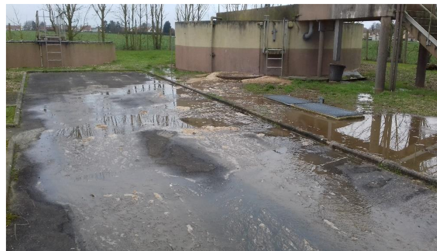
Figure 1 : Débordement du silo de stockage et présence de boue sur la station
